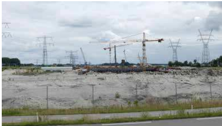
Verbreiding A1 en bouw aquaduct bij Muiden
