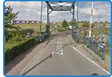
Kruispunt 9. Brug Zuidpolderweg-Naarderstraat
