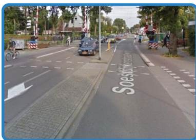
1. Soestdijkerstraatweg vóór spoorwegovergang
