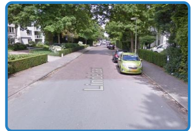
15. Lindenlaan overgang asfalt-tegels
