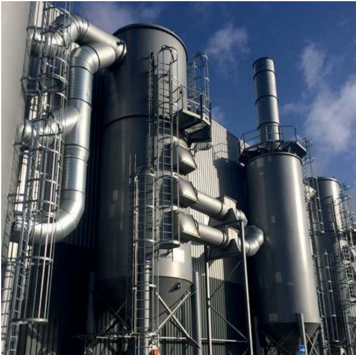
Scheidingsinstallatie AEB Amsterdam
