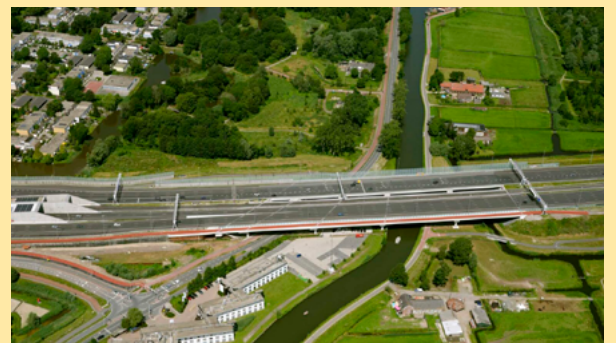
Fietsbrug over de Gaasp
