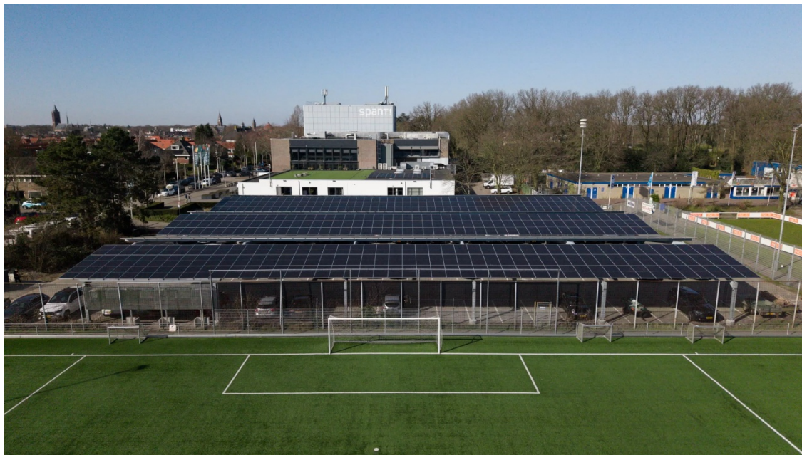
Figuur 1 Solar Carport De Kuil Bussum
